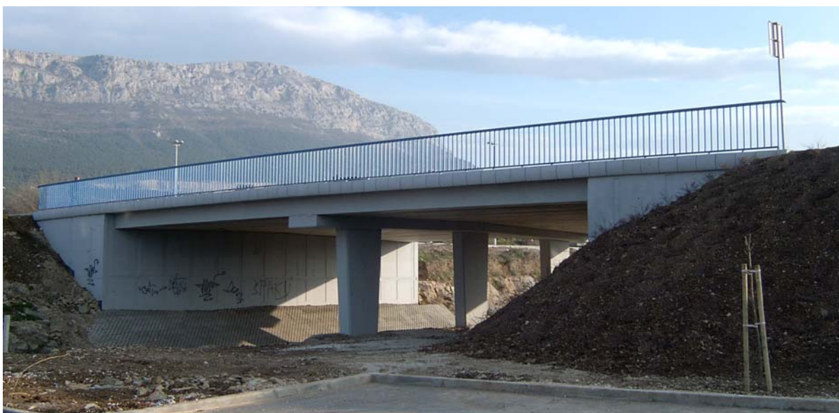
Crtež 5.11: Masivni upornjak s paralelnim krilima
