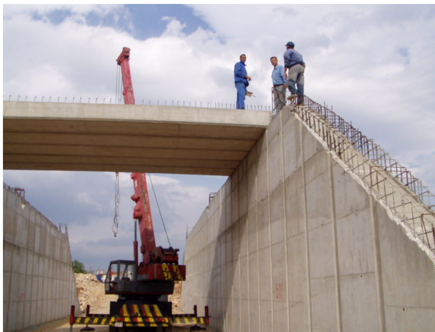
Crtež 5.12: Masivni upornjak s okomitim krilima (u gradnji)
