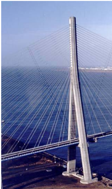
Pont de Normandie, Francuska
