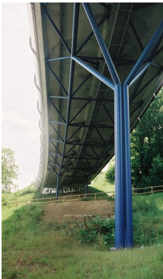
Primjer suvremene pasarele s lakim pojedinačnim stupovima
