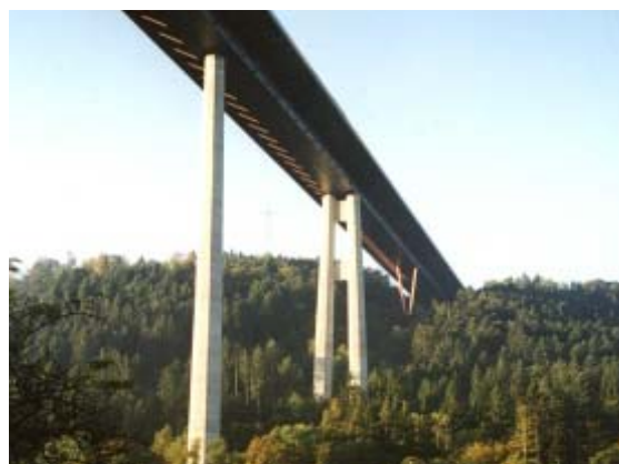
Most Neckarbrücke, Njemačka
